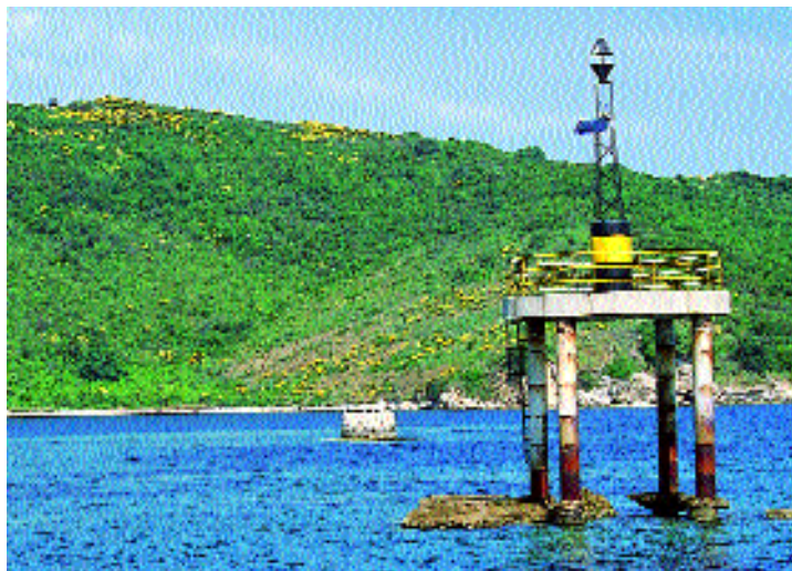
Il cardinale Est che segnala la secca di Serpa, sulla costa NE di Corfù
